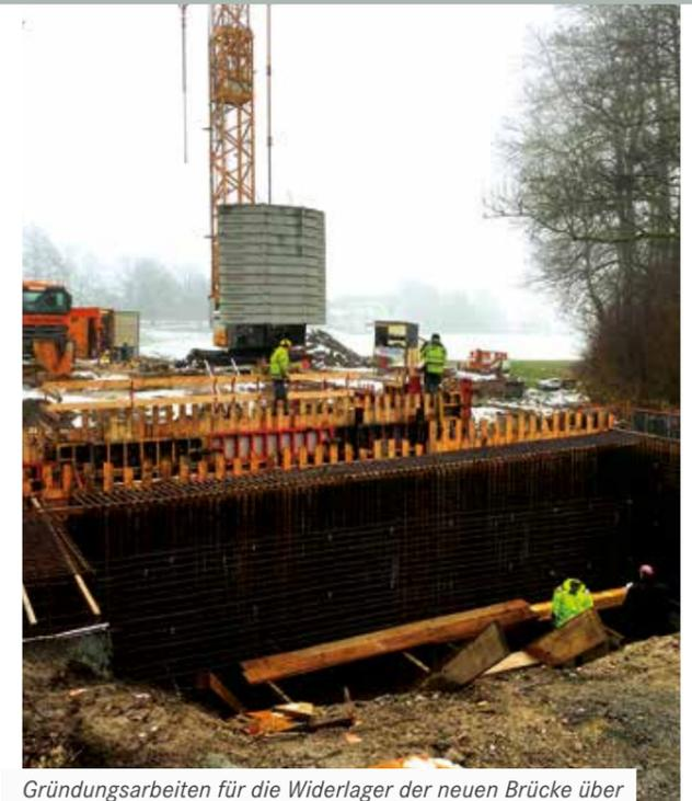
Gründungsarbeiten für die Widerlager der neuen Brücke über die Schussen, Abnahme der Bewehrung und Betonieren der neuen Widerlager
