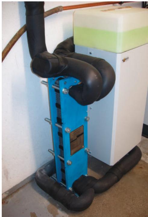
obere Reihe links: gelötete Trennwärmetauscher; unten: zwischen Brunnen und Wärmepumpe im Heizbetrieb;
